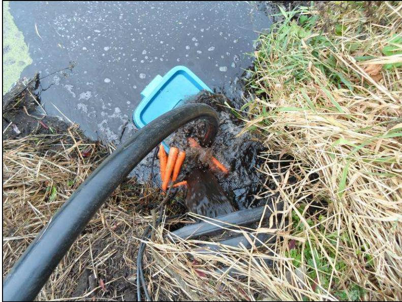
**Figure 23.** Bac troué contenant la pompe submersible installée au site 2.
