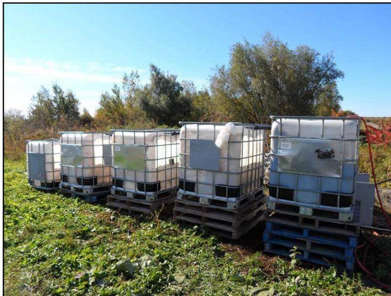
**Figure 22.** Bassins de sédimentation installés en série au site 2.
