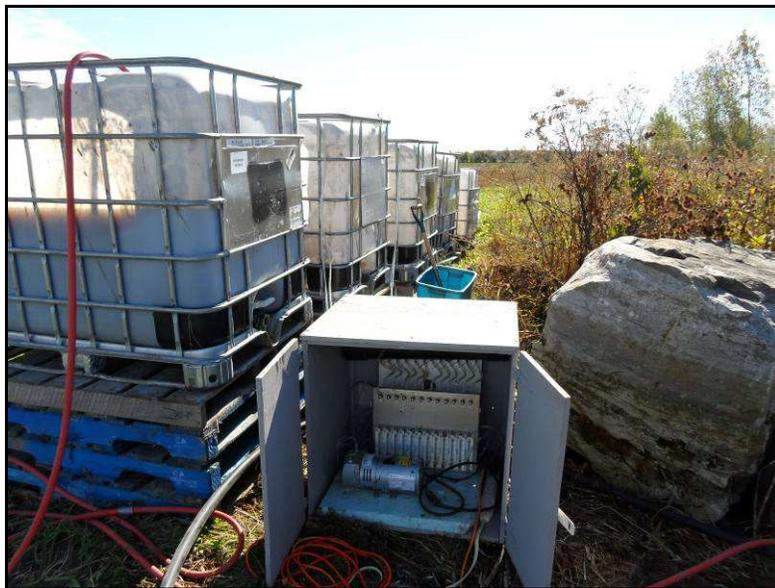
**Figure 24.** Système d'aération installé au site 2.
