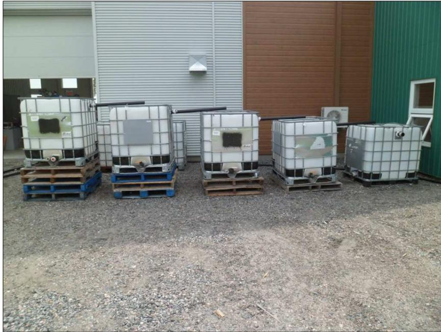
**Figure 4.** Chaîne de traitement des eaux de lavage.
