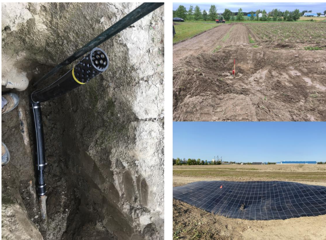
Figure 5. Réfection des avaloirs, des risbermes et des aires de captage.
