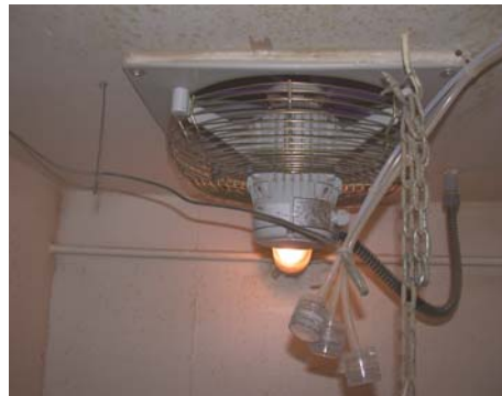
Figure 10 : Localisation pour le prélèvement des gaz et des odeurs
