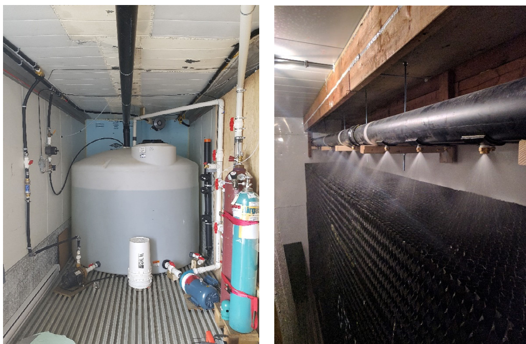
Figure 2. Photos du système de gestion de l'eau (gauche) et de l'arrosage du mur filtrant (droite).
