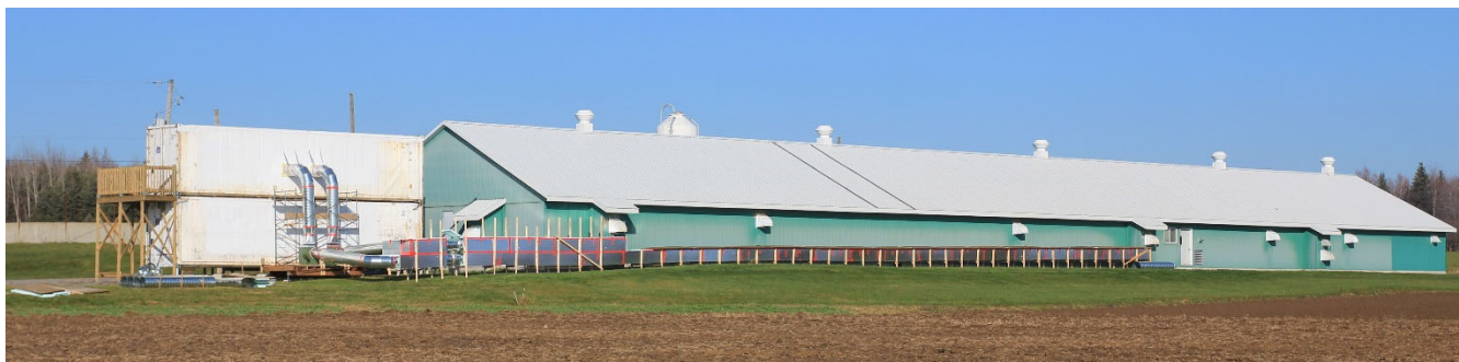
Figure 1. Photo du système de traitement de l'air installé sur la porcherie.
