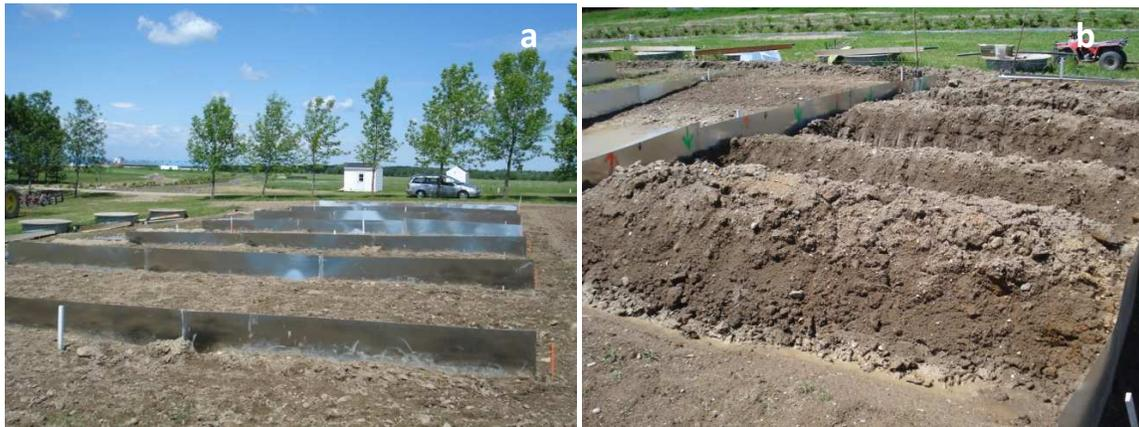
**Figure 5. Installation des tôles galvanisées pour séparer les bandes végétatives (a) et profilage de 5 baissières pour le traitement 5 (b).**
