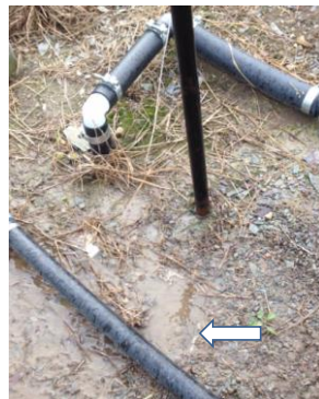
(a) (b) Figure 2. Fuite de la valve souterraine (a) et son impact potentiel sur l'uniformité et la consommation d'eau (b)
