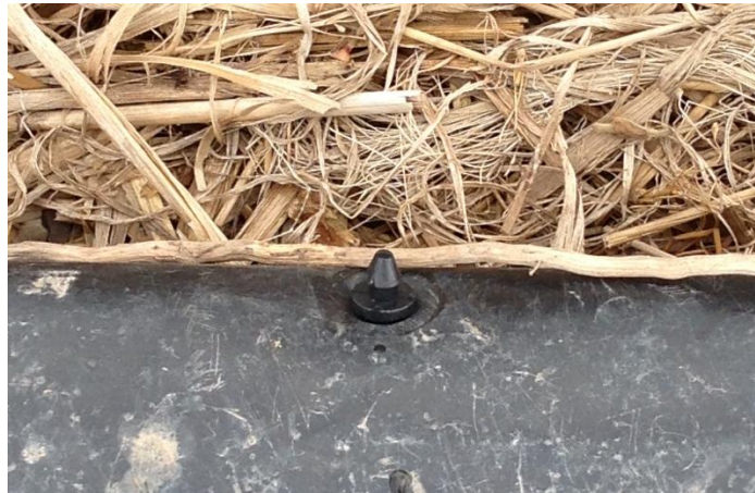
Figure 18. Bouchon réparateur « goof plug »
