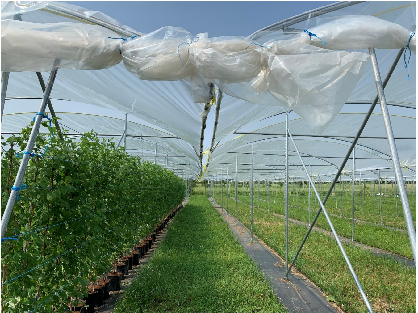
Figure 14. Jonction entre les chapelles où l'installation de la gouttière a été planifiée, 10 juillet 2019.
