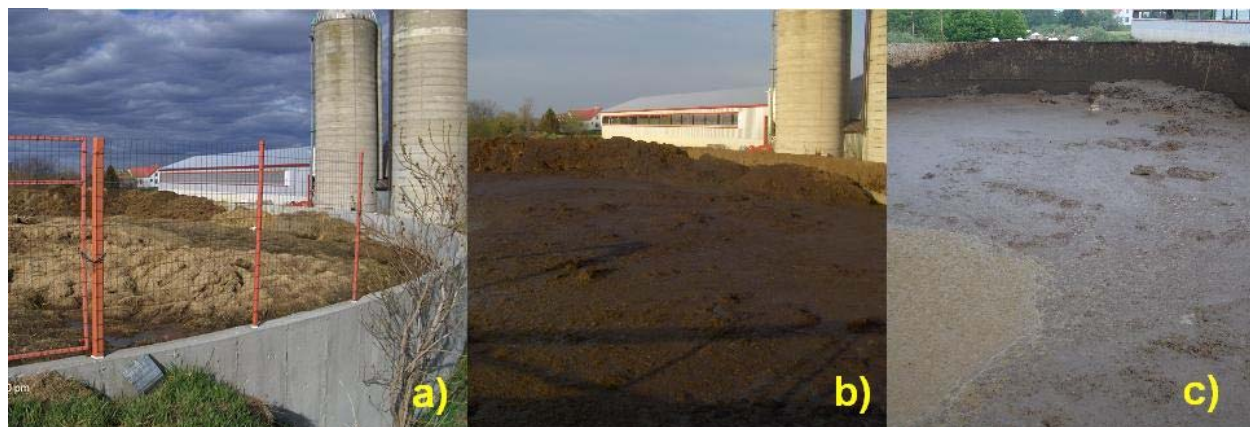
Figure 3 : Fosse du site C a) le 4 mai 2007 avant le premier brassage; b) le 10 mai 2007, après le premier brassage et c) le 27 juin après 5 heures de brassage et pompage
