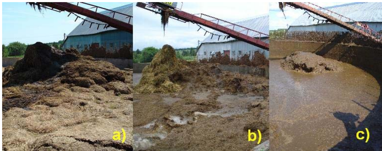
Figure 2 : Fosse du site B a) le 12 juin 2007 après le premier brassage en mai et avant le deuxième brassage du 20 juin; b) le 20 juin 2007, après 2 heures de brassage et c) le 21 juin après 10 heures de brassage et pompage
